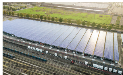
NELLE FOTO SOPRA LE FIAT 500 ELETTRICHE UTILIZZATE PER LA SPERIMENTAZIONE. IN ATTESA DI ESSERE SPEDITE AI CLIENTI. PIÙ IN BASSO I PANNELLI FOTOVOLTAICI INSTALLATI SULLE PENSILINE PER FORNIRE ENERGIA ALL'IMPIANTO
