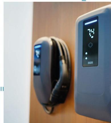
L'INSTALLAZIONE REALIZZATA DA E.ON PRESSO THE GREEN QUEST HOUSE (BAROLO, CUNEO), CON UNA WALL BOX IN AC CHE SUPPORTA LA RICARICA AUTENTICATA VIA RFID CARD
