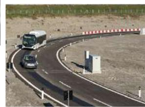
In un'area privata dell'autostrada A35 (BreBeMi), in prossimità dell'uscita Chiari Ovest, è in corso di sperimentazione un progetto di ricarica induttiva dinamica senza contatto chiamato Arena del Futuro, che applica la tecnologia "Dynamic Wireless Power Transfer" per la ricarica di mezzi leggeri (500e) e pesanti (Iveco e Iveco Bus) in movimento. Si tratta di un anello di bobine posizionate a 10 cm di profondità nell'asfalto autostradale e sotto il pianale dei veicoli circolanti, con l'obiettivo
