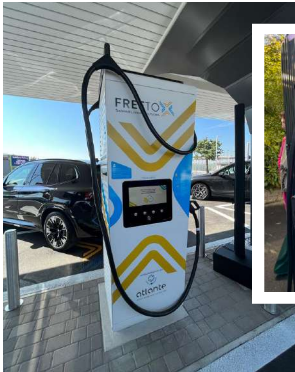
DUE ESEMPI DI COLONNINE ULTRAFAST E FAST TRA LE PIÙ DIFFUSE. QUELLA DI FREE TO X È UN HYPERCHARGER ALPTRONIC CON 4 PUSH BUTTON CHE CONSENTONO DI NAVIGARE TRA LE VARIE FUNZIONI. MENTRE LA WALLBOX SUPERNOVA DI ATLANTE PREVEDE LA PRESENZA DI UNO SCHERMO TOUCHSCREEN
