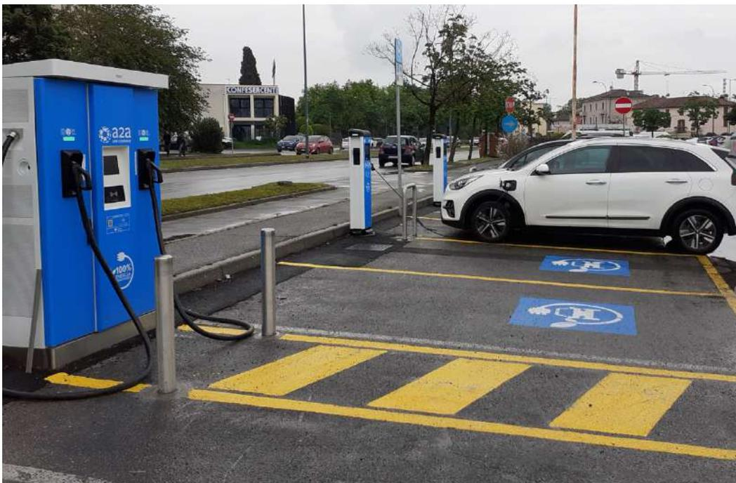
IN ITALIA UNA DELLE INSTALLAZIONI AD ACCESSO PUBBLICO PIÙ IMPORTANTI TRA QUELLE CHE IMPIEGANO PRODOTTI CIRCONTROL. È QUELLA REALIZZATA DA A2A PRESSO IL POLO COMMERCIALE NUOVO FLAMINIA DI BRESCIA, DOVE È PRESENTE UNA RAPTION 150 IN DC E DUE COLONNINE EVOLVE MASTER IN AC DA 22 KW
