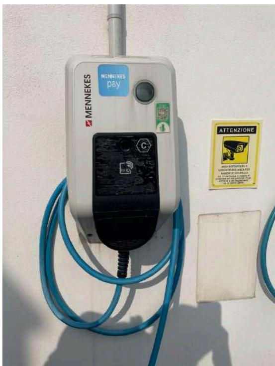
LE WALL BOX AMTRON PROFESSIONAL IMPIEGATE DA DIVITA SONO COLLEGATE A UN IMPIANTO FOTOVOLTAICO RELIZZATO DA SUNPOWER. HANNO UN CAVO INTEGRATO DI TIPO 2 E UNA POTENZA FINO A 22 kW IN AC
