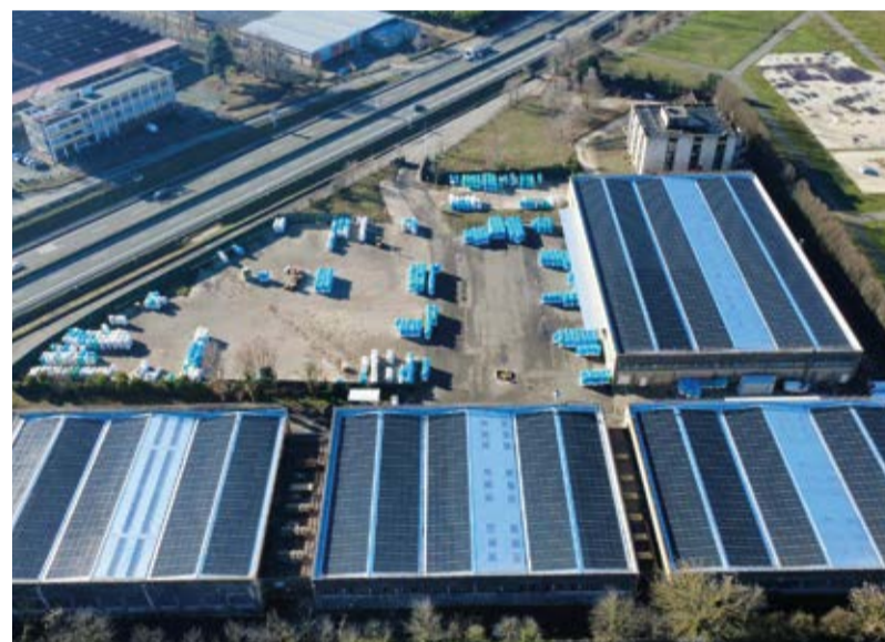
AZIENDE COME SEVAL IN ITALIA HANNO SVILUPPATO UNA SERIE DI TECNICHE AVANZATE DEDICATE AL TRATTAMENTO DELLE BATTERIE AGLI IONI DI LITIO
