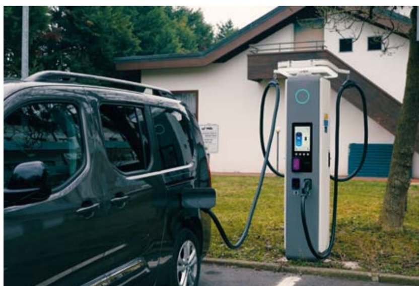
LA STAZIONE COMBINA COLONNINA HPC FINO A 240 KW E RICARICA LENTA IN AC
